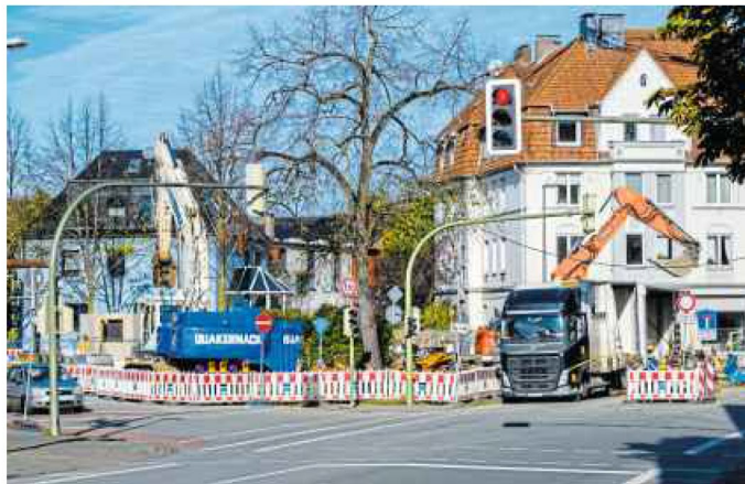
Vor der ehemaligen Hammer Mühle wird zunächst der Kanal erneuert und später die Lutter offengelegt.
